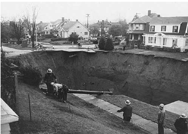
Rys. 1. Zapadlisko powstałe po zawaleniu się kanału w Seattle w 1957 roku [4]
