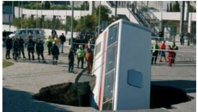
Rys. 2. Autobus po zapadnięciu się w obszar pustki powietrznej nad nieszczelnym kanałem w Lizbonie [4]
