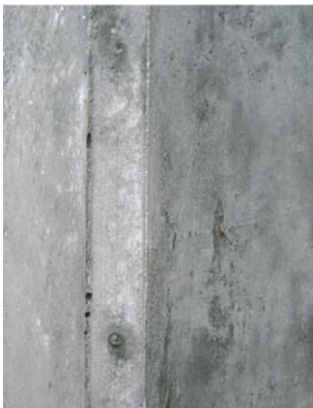
Fot. 11. Beton architektoniczny, z powierzchnią gładką, uzyskaną bezpośrednio z form
