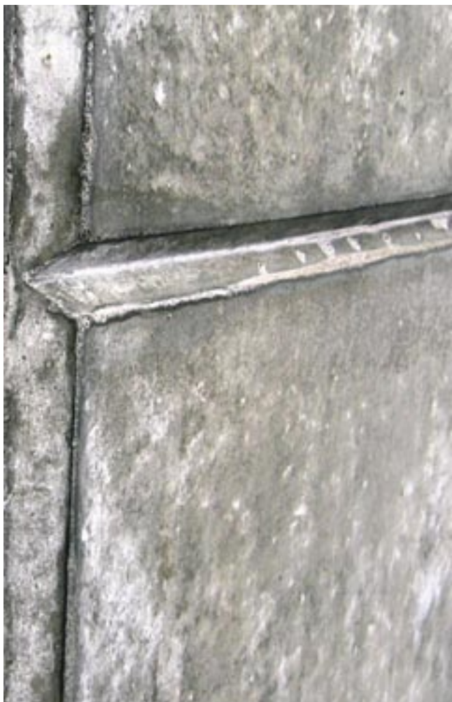
Fot. 12. Fragment elewacji wykonany z betonu architektonicznego
