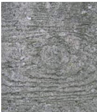
Fot. 3. Fragment struktury betonu architektonicznego z wykorzystaniem matryc stylizowanych na deski z drewna
