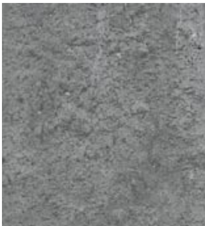
Fot. 5. Struktura powierzchni betonu architektonicznego, wykonanego w deskowaniach inwentaryzowanych, wyłożonych gładkimi płytami laminowanymi
