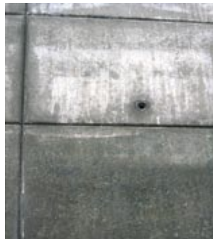
Fot. 2. Element fasady wykonany z betonu architektonicznego o gładkiej powierzchni
