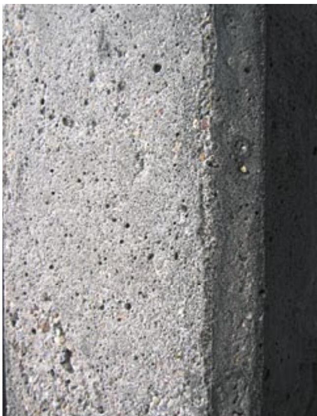
Fot. 10. Beton architektoniczny, z powierzchnią poddaną procesowi piaskowania
