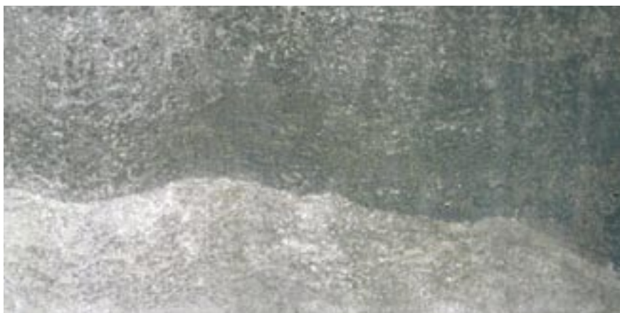
Fot. 7. Fragment powierzchni betonu architektonicznego z widocznym odcięciem barwy, wynikającym z dostawy mieszanki betonowej o różnych parametrach, w tym przypadku konsystencji mieszanki betonowej. Badania konsystencji wykazały, że rozptyw stożka wyniósł 3 cm więcej niż podczas dostawy poprzedniej partii
