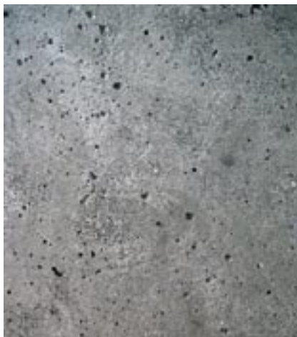
Fot. 1. Beton architektoniczny
