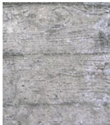
Fot. 4. Fragment struktury betonu architektonicznego z wykorzystaniem matryc stylizowanych na deski z drewna
