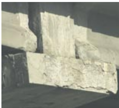
Rys. 2. Przykłady skorodowanych elementów mostowych
