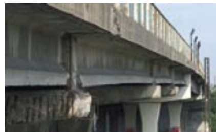
Rys. 1. Widok skorodowanych elementów mostu drogowego nad torami kolejowymi
