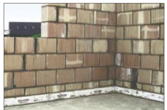
Fot. 3. Przykład realizacji ściany opartej na pustakach ISOMUR
