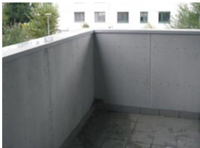
Balustrada balkonu – okładzina konstrukcji płytą Aquapanel Outdoor
